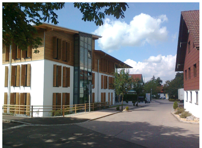
Kolpingweg Richtung Norden mit Seniorenzentrum links und Getränkemarkt rechts
