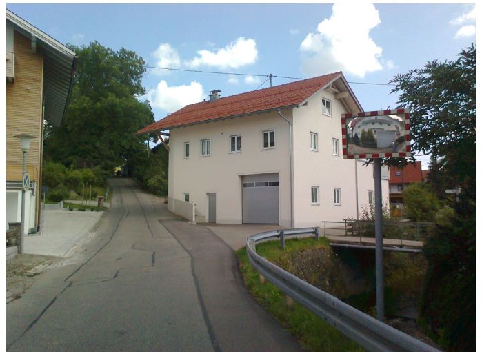
Kempter-Wald-Straße Richtung Südosten im Bereich der neu geplanten Brücke zur Kirchstraße
