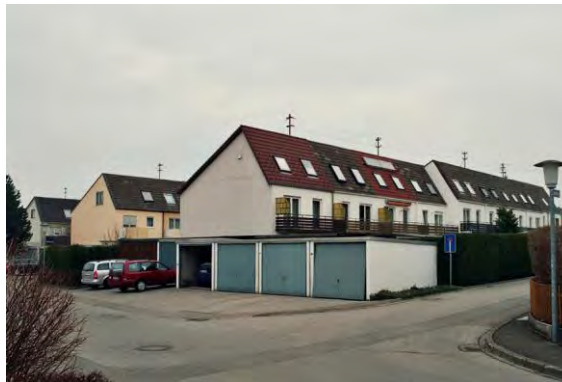
Sammelgaragen und eine eigenwillige Dachform in der Geierstraße
