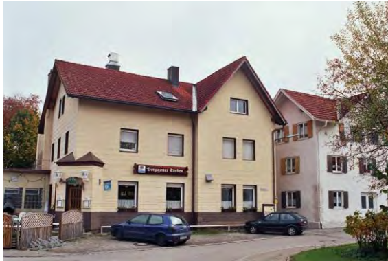
Ehemalige Bahnhofsgaststätte mit Eternitverkleidung
