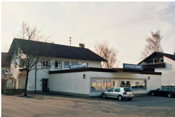
Flachdachgebäude für Drogeriemarkt in der Hauptstraße
