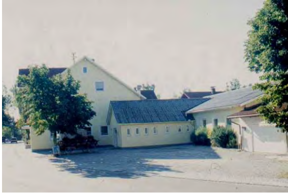
Der am Gasthaus Hirsch angebaute Saal mit Nebenräumen soll als gesellschaftliches Zentrum grundlegend erneuert werden
